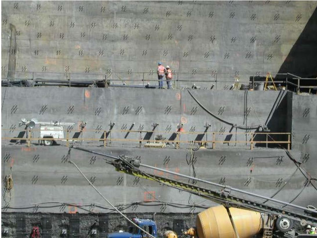
**Figura 3.13: Vista frontal de un muro clavado. Se observan los pernos de sujeción del paramento definitivo de hormigón armado sobresaliendo de la superficie gunitada.**
