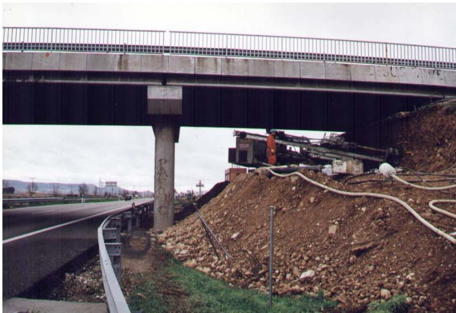
**Figura 2.2: Ejecución de bulones para la ampliación de calzada bajo estructura. Azuqueca de Henares (A2). (Cortesía de SITE).**
