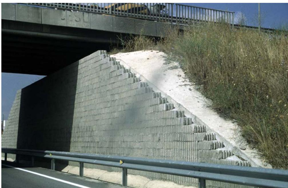
**Figura 3.10: “Forro” de cubrición del paramento de gunita en el desmonte claveteado de la figura 2.2. (Cortesía de SITE).**
