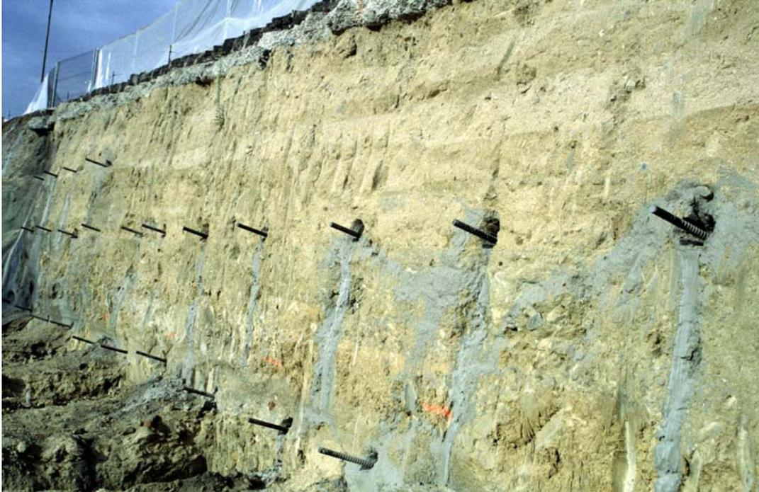
**Figura 1.2: Disposición de bulones de clavado en malla regular cuadrada. San Sebastián de los Reyes, Madrid. (Cortesía de SITE).**
