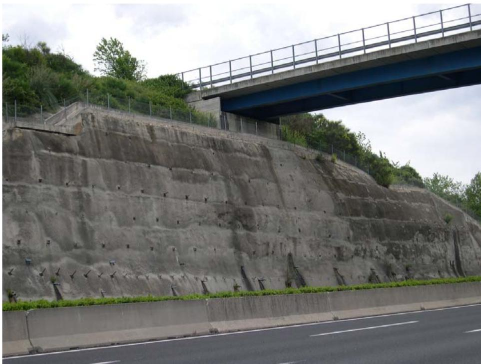
**Figura 1.3: Talud clavado bajo estribo de estructura. Se observan las alineaciones de bulones, la gunita del paramento y algunos drenes hacia la base. Autopista Roma-Nápoles.**
