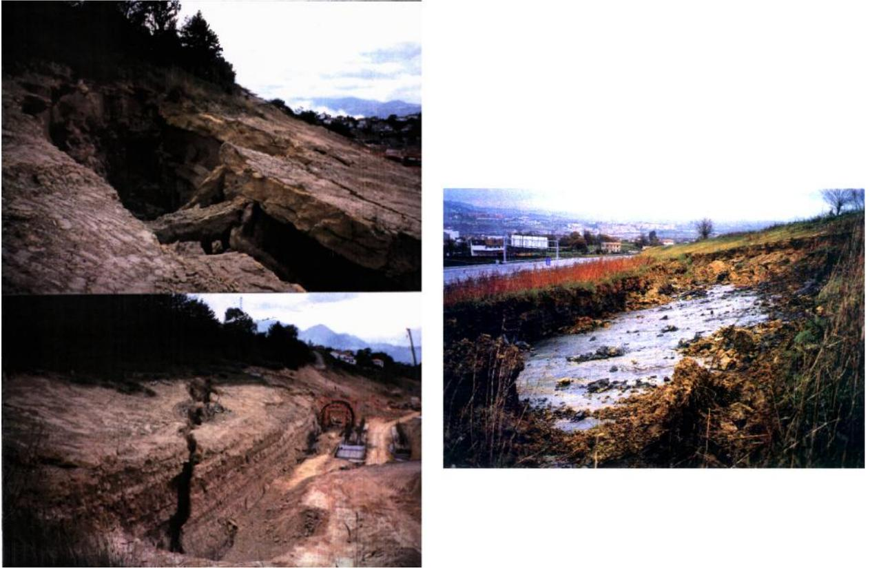
***Figura 3.2: Deslizamientos traslacionales en la autovía del Cueto.***
