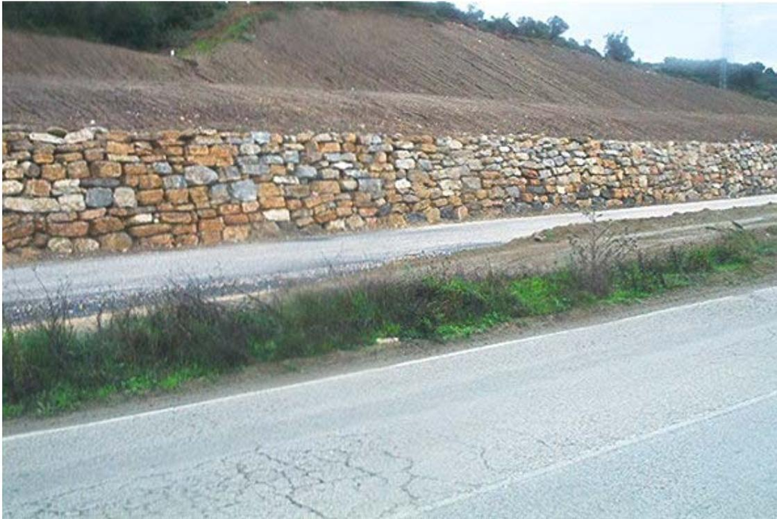
**Figura 3.5: Muro de escollera y relleno de trasdós en desmonte.
