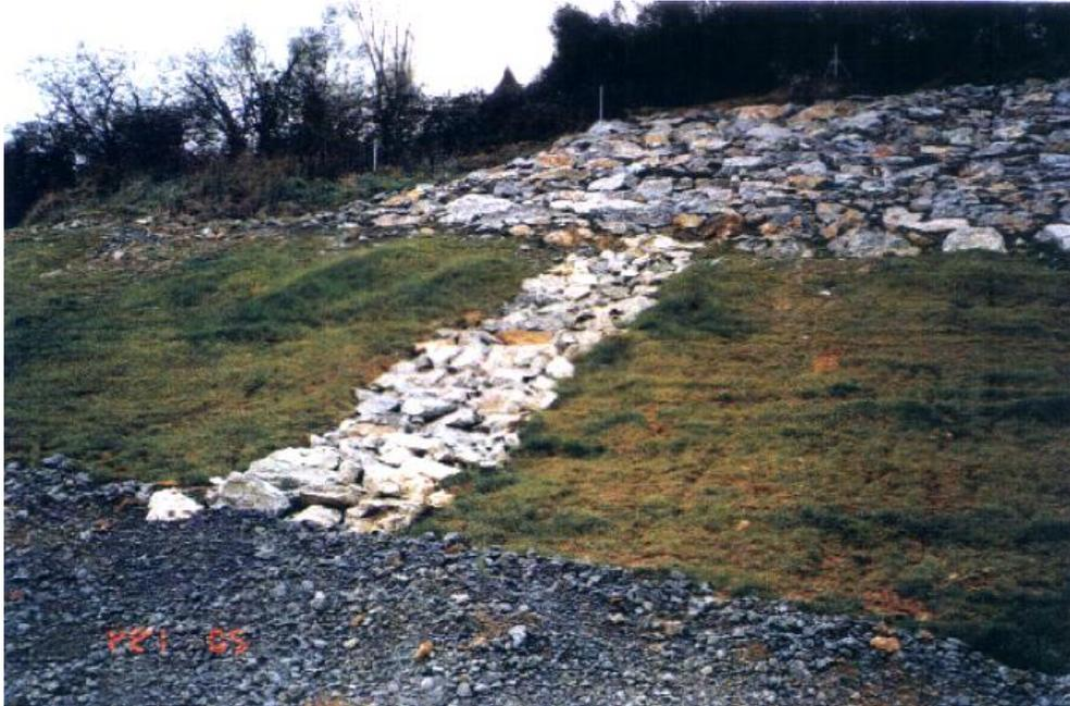
**Figura 3.15: Detalle de los encachados ejecutados y zanjas de drenaje en la autovía del Cueto.**
