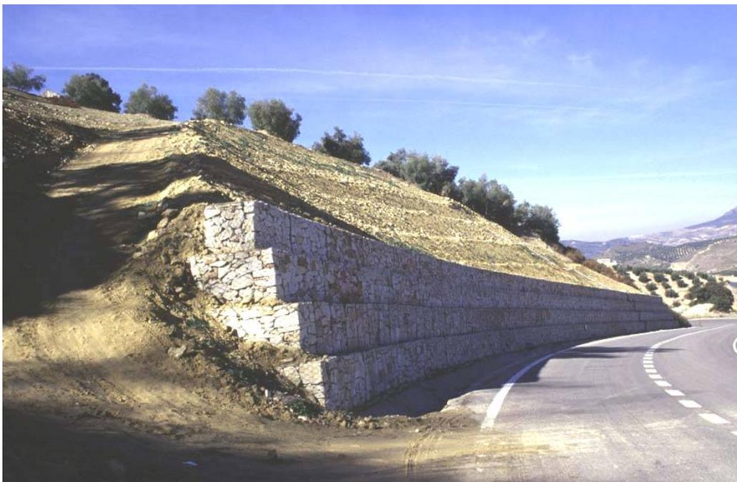
**Figura 3.11: Combinación de gaviones y relleno estabilizador empleado en la carretera Rute-Iznajar-**
