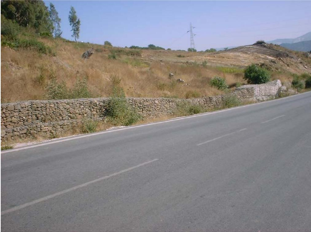
**Figura 3.8: Contención de gaviones deformada en la carretera Jerez-Los Barrios.**
